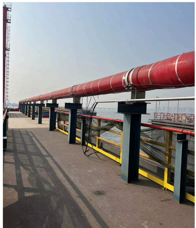
Fire Pipe in LNG Station
