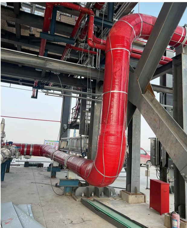
Fire Pipe in LNG Station
